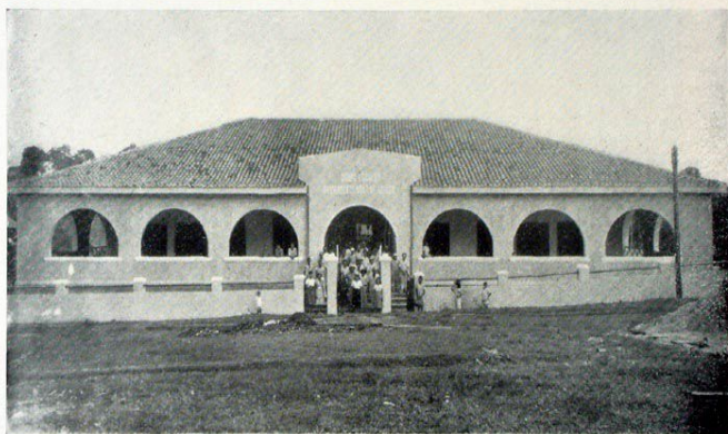
Município de Cruzeiro do Sul. — Grupo Escolar após a conclusão. Recebeu o nome de “Comte. Braz de Aguiar”, um dos benfeitores da cidade.
